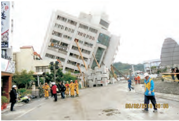
雲門翠堤大樓向東南方倒塌傾斜
